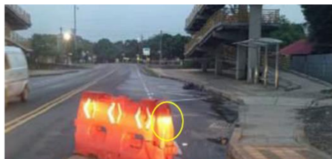
Se observa en el círculo amarillo la reflectividad del maletín en sus laterales
